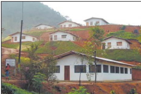
L'association a financé la construction de dix maisons et d'un centre d'accueil (au premier plan), qui sert également d'école pour les enfants. DR
